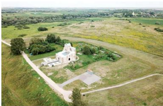
Рис. 18. Современный общий вид на Городище после реставрации руин церкви Благовещения в 2018 г. (по Е.Н. Носову и Н.В. Хвоцинской [40])
