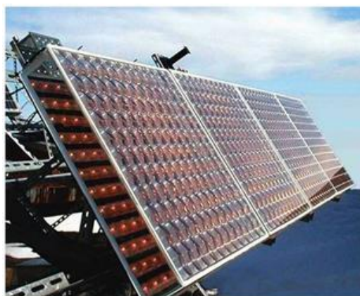
Рис. 22. Солнечная батарея на основе 576 каскадных солнечных элементов и концентраторов – линз Френеля на системе ориентации на Солнце
